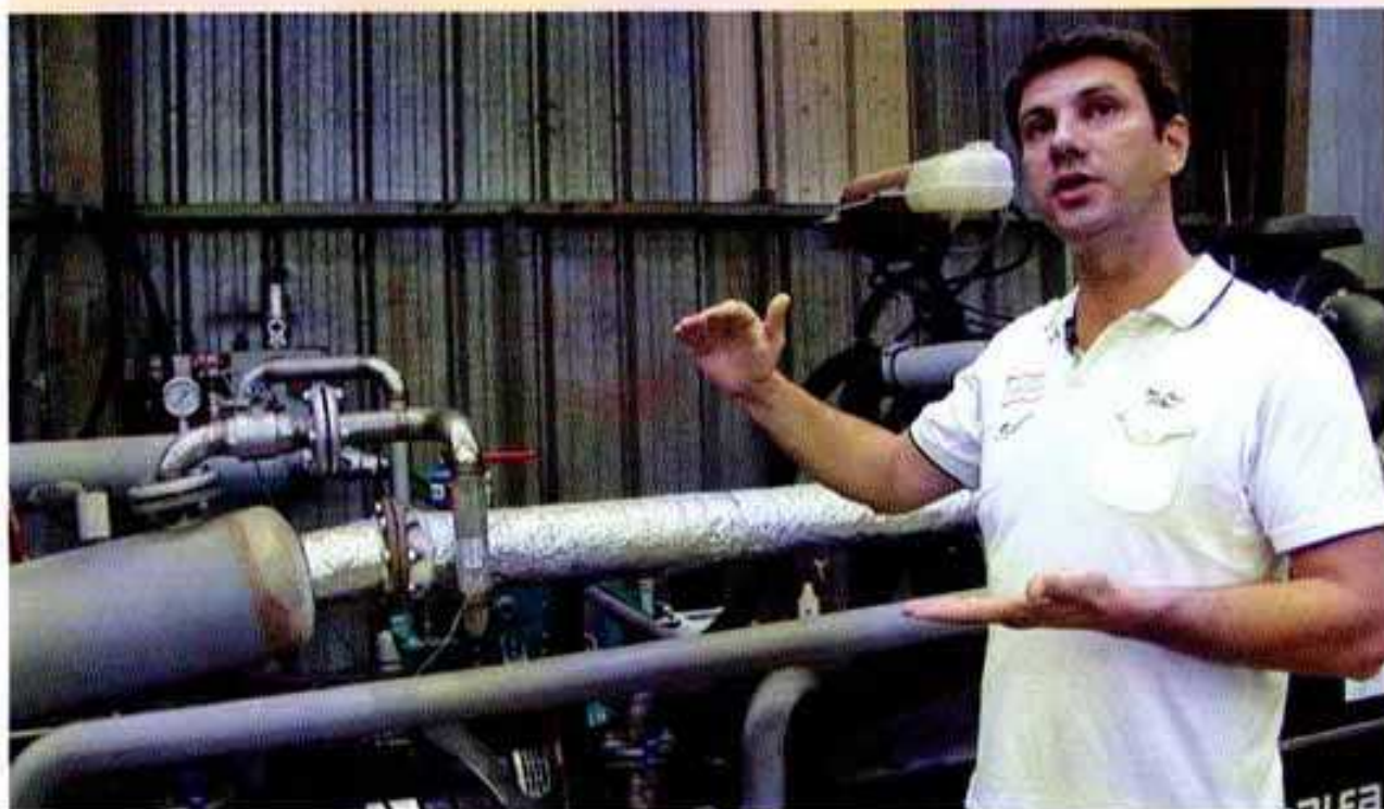
Avec ce module additionnel, Le Floch diminue la consommation de carburant de 75 % des installations énergétiques et nautiques.
