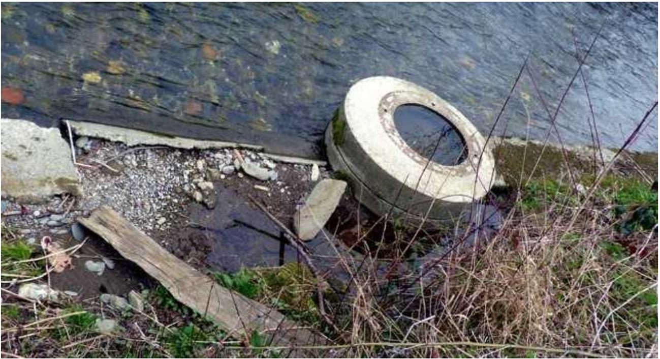
Alors que les crues de l'Arize n'ont rien de comparable avec la violence des crues du Salat, une conduite d'assainissement placée en berge y est en piteux état : couvercle défoncé, protection en béton éclatée, le tout hors d'usage.
